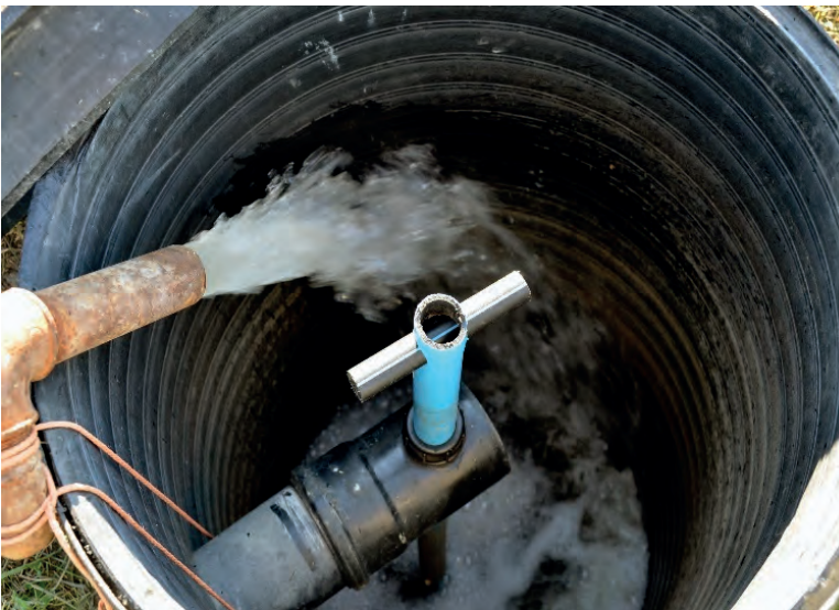
Kuva 4.5. Altakastelu käytännössä, vettä pumpataan ojaan. Kuva: Rainer Rosendahl
