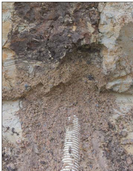
Suomessa salaojaputken ympärysaineena käytetään pääasiassa salaojasoraa.
